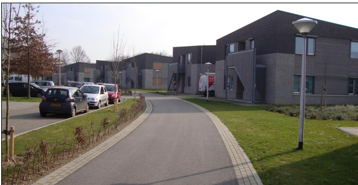
De vijf nieuwe woongebouwen die tijdens fase 1 van de herstructurering zijn gerealiseerd
